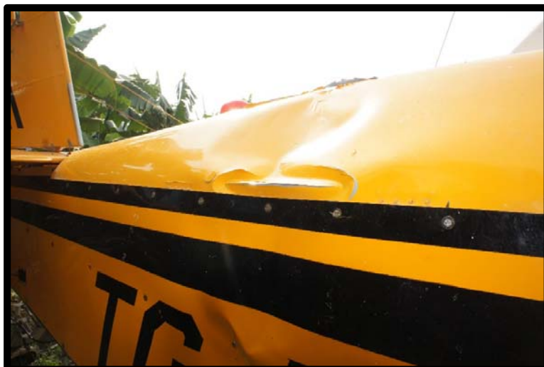
FOTOGRAFIA No. 7 DAÑOS EN EL FUSELAJE
